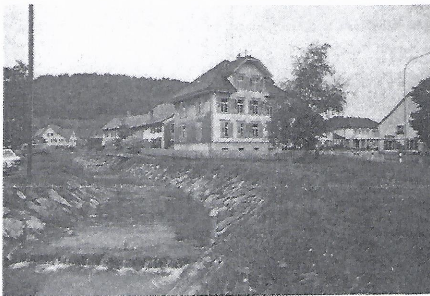
Früher führte der Bachlauf neben der Strasse rechts von diesen Häusern durch. Nun ist die Bachverlegung abgeschlossen.
