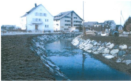
1980 nach der Bachverlegung
